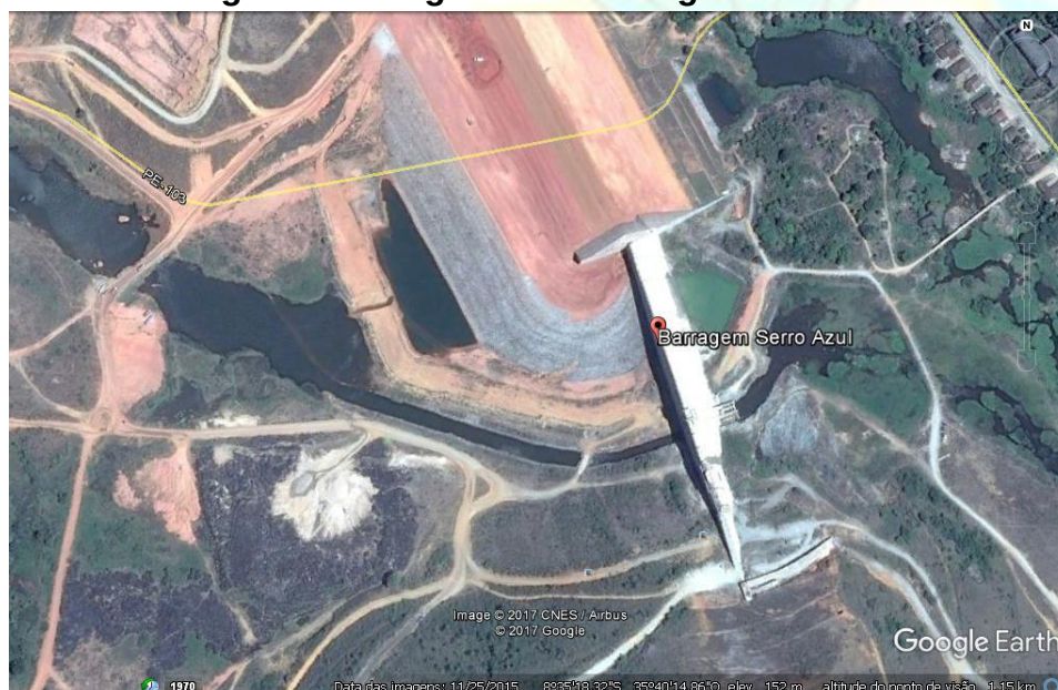
Figura 72 - Registro da Barragem de Serro Azul
