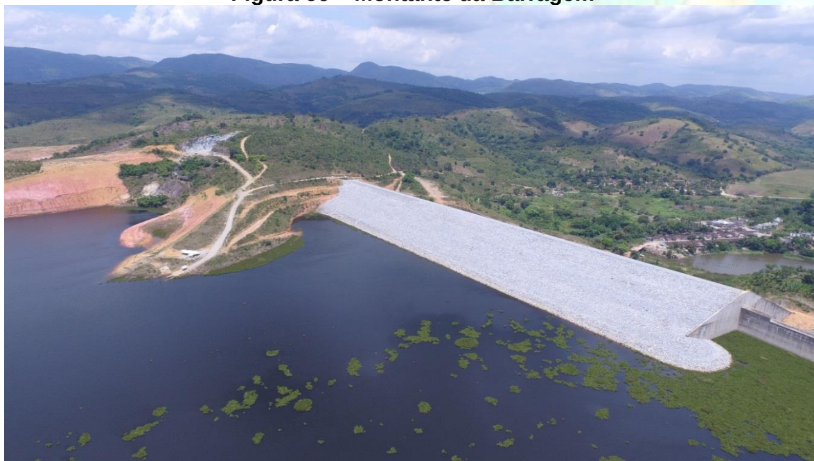
Figura 66 – Montante da Barragem
