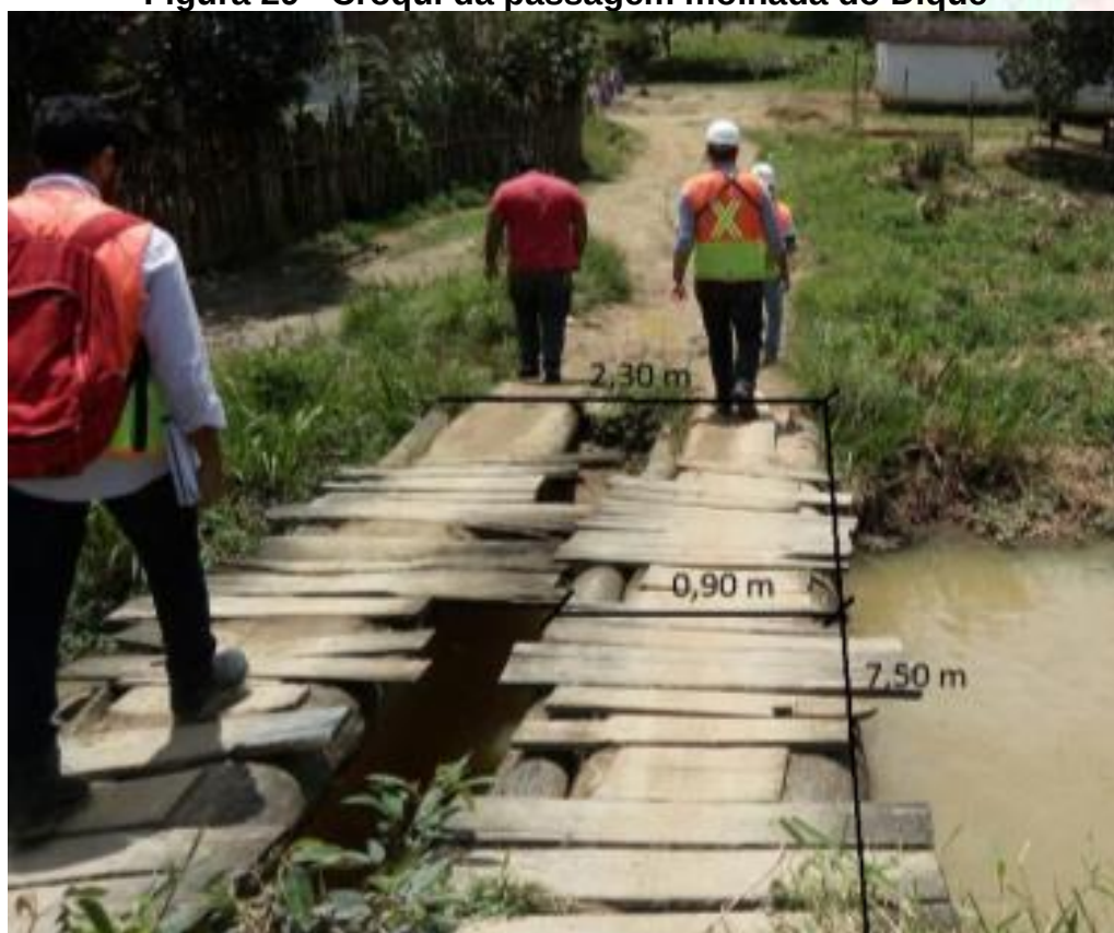
Figura 29 - Croqui da passagem molhada do Dique
