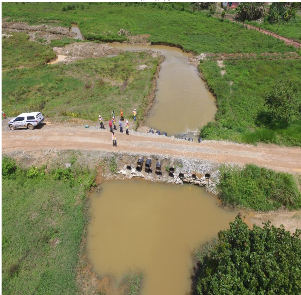
Figura 56 - Passagem molhada parcialmente recuperada na Zona Rural de Palmares
