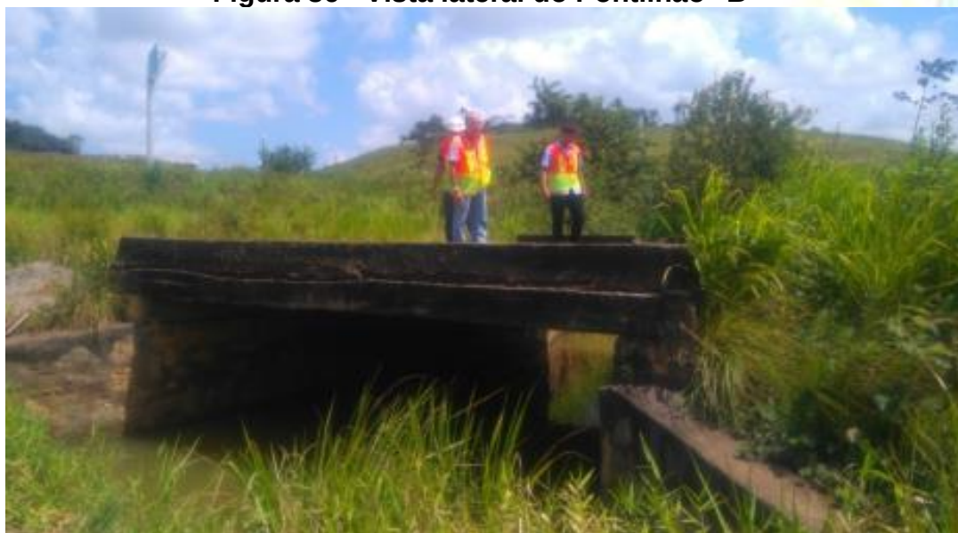
Figura 36 - Vista lateral do Pontilhão "B"
