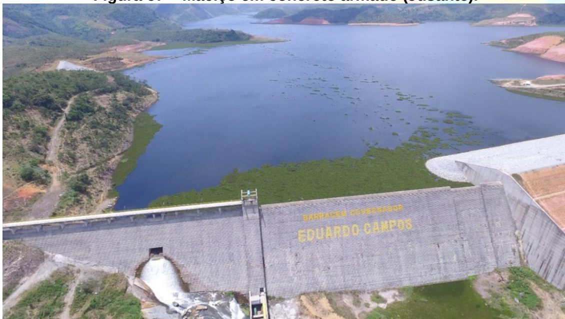
Figura 67 – Maciço em concreto armado (Jusante).
