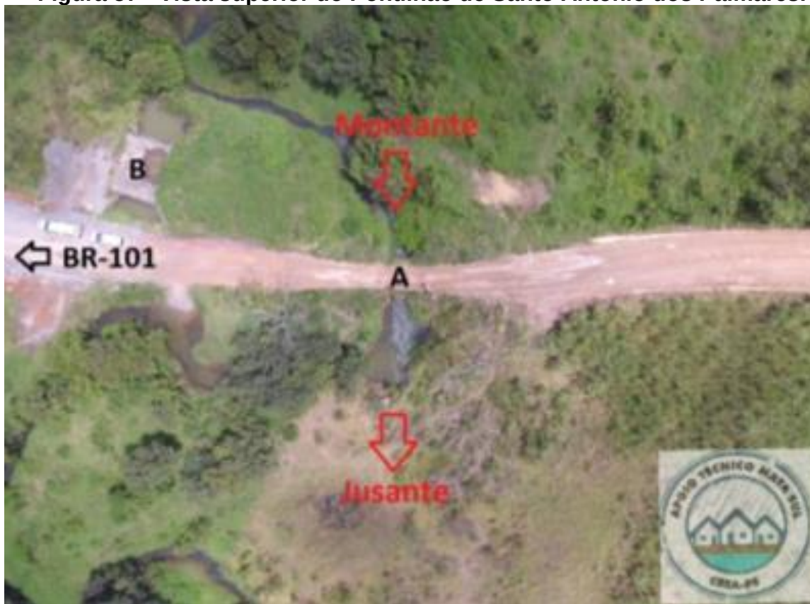
Figura 57 - Vista superior do Pontilhão de Santo Antônio dos Palmares.
