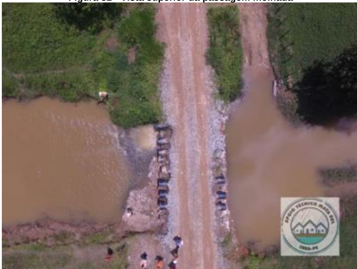
Figura 32 - Vista superior da passagem molhada
