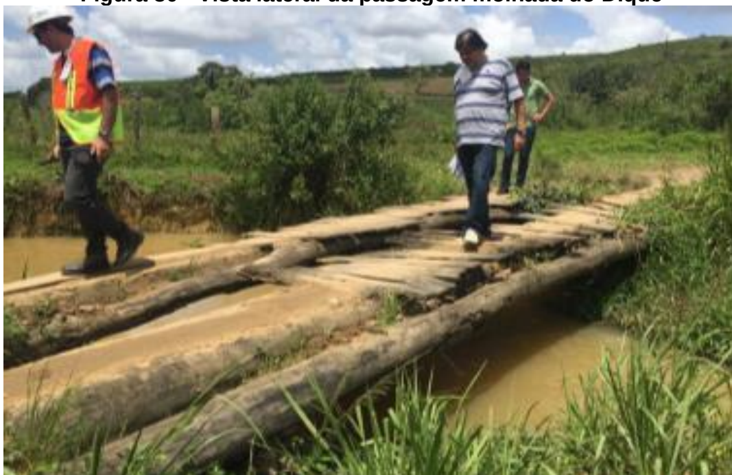
Figura 30 - Vista lateral da passagem molhada do Dique
