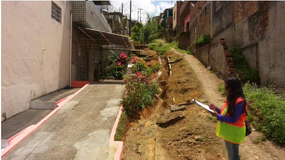
Figura 38 - Pé do talude da Rua 9
