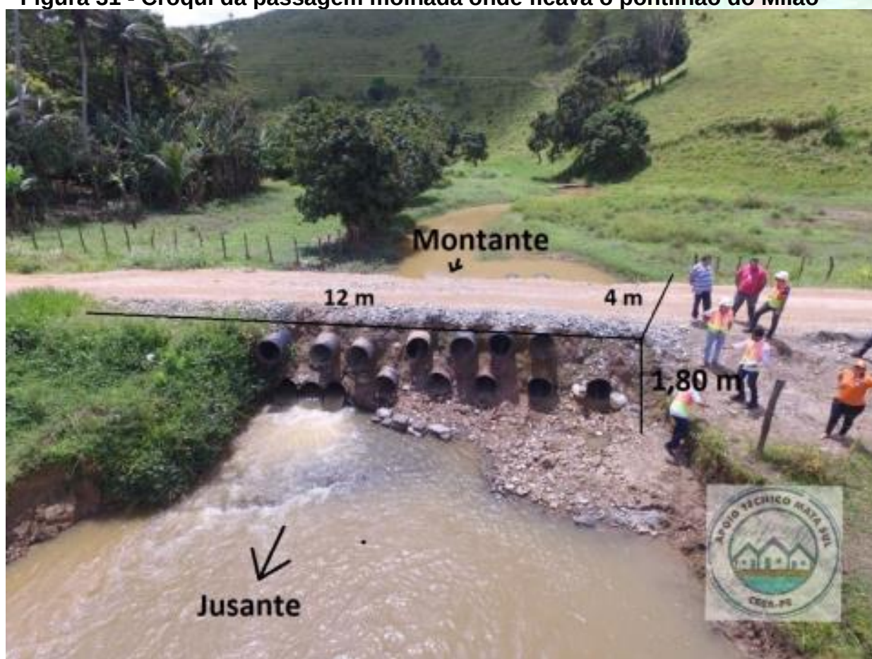
Figura 31 - Croqui da passagem molhada onde ficava o pontilhão do Milão
