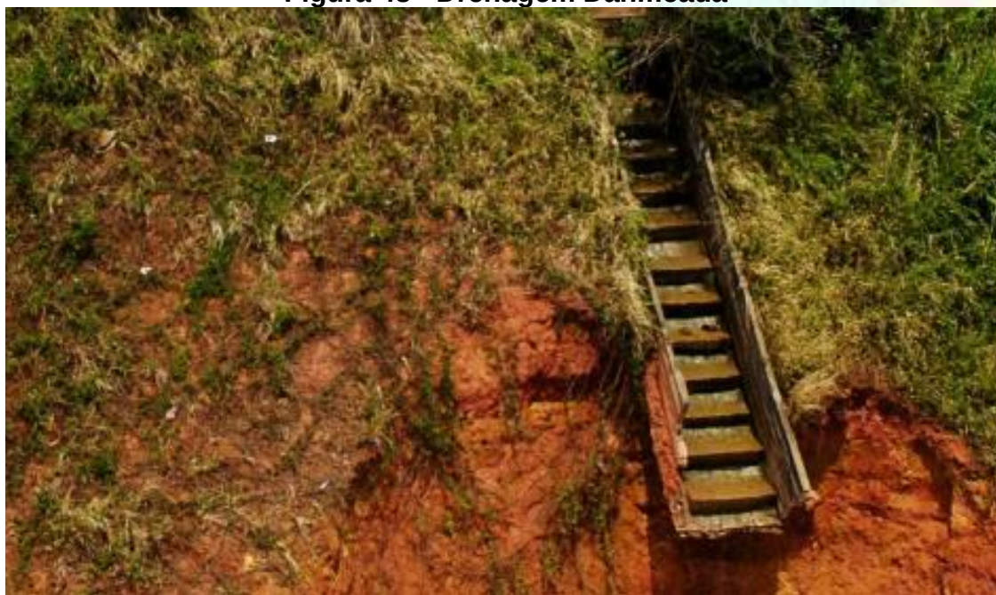
Figura 48 - Drenagem Danificada
