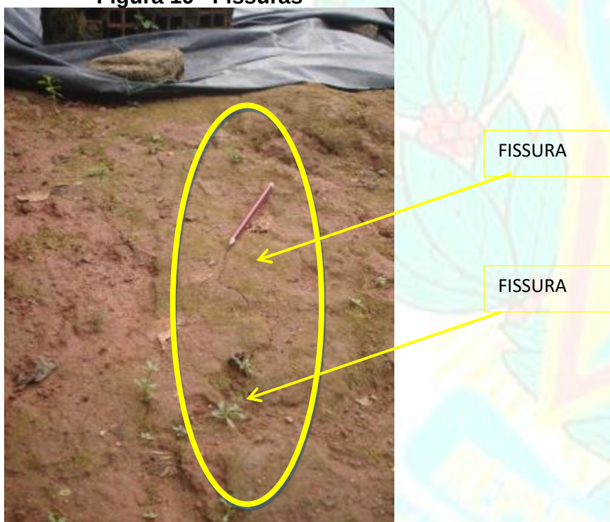
Figura 19 - Fissuras
