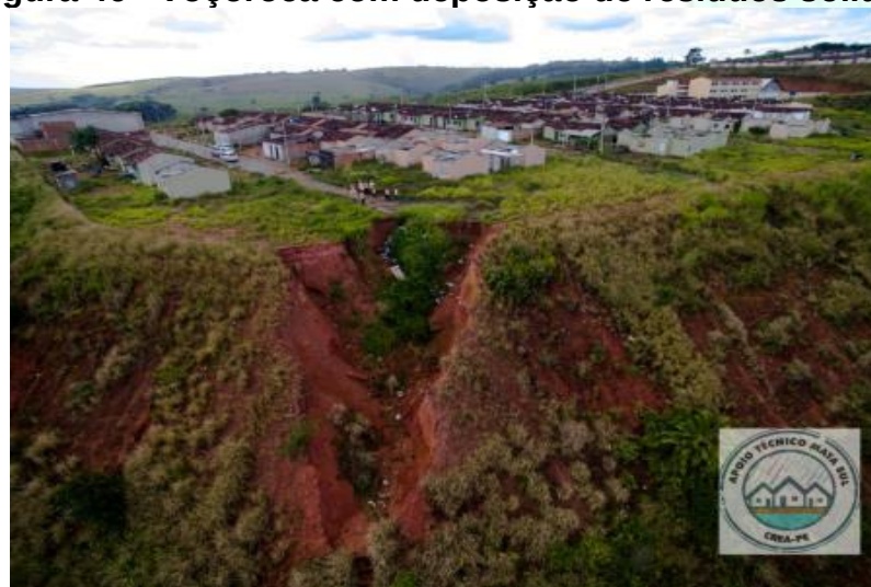
Figura 46 - Voçoroca com deposição de resíduos sólidos
