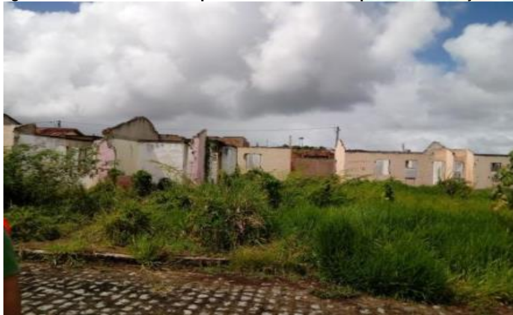
Figura 50 – Imóveis desocupados e condenados próximo as voçorocas
