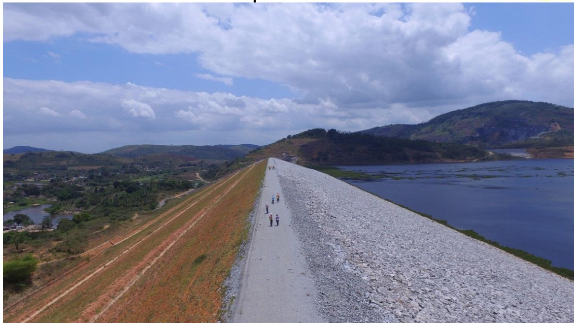
Figura 65 – Talude Formado de Rocha Granítica e Solo (Montante E Jusante) respectivamente
